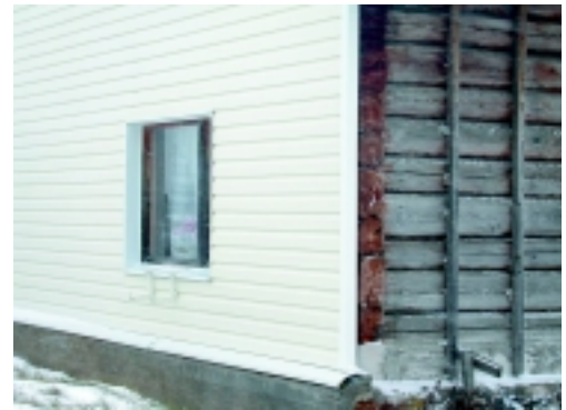
Plastvooder ei sobi ajaloolisele puithoonele. Plastvooder jätab tehniliku ja ajapikku ka määrdunud mulje, rikkudes pealegi hoone niiskuse- ja ajapikku ka tekivad haige maja sündroomi. Vana puitmaja välisviimistluses tuleb kasutada naturaalseid ehitusmaterjale.
