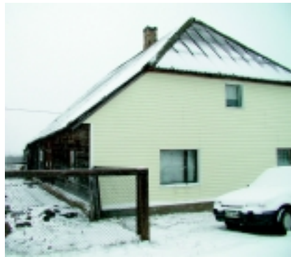
Plastvooder ei sobi ajaloolisele puithoonele. Plastvooder jätab tehniliku ja ajapikku ka määrdunud mulje, rikkudes pealegi hoone niiskuse- ja ajapikku ka tekivad haige maja sündroomi. Vana puitmaja välisviimistluses tuleb kasutada naturaalseid ehitusmaterjale.
