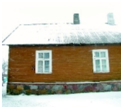
Vana maja akende uuendamisel tuleb jälgida, et säiliks akende jaotus ja raami laius. Kahekordsel aknal võib vajaduse korral asendada sisemise akna, mille vahetus ei muuda märgatavalt hoone fassaadi. Puithoone puhul tuleb kindlasti vältida õhu- ja niiskustihedate niiskuskindlate plastakende paigaldamist (vt parempoolne pilt).
