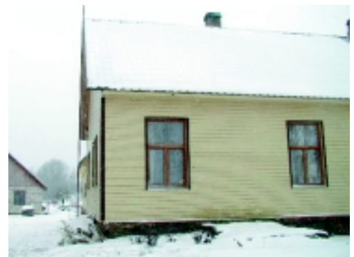
Vana maja akende uuendamisel tuleb jälgida, et säiliks akende jaotus ja raami laius. Kahekordsel aknal võib vajaduse korral asendada sisemise akna, mille vahetus ei muuda märgatavalt hoone fassaadi. Puithoone puhul tuleb kindlasti vältida õhu- ja niiskustihedate niiskuskindlate plastakende paigaldamist (vt parempoolne pilt).
